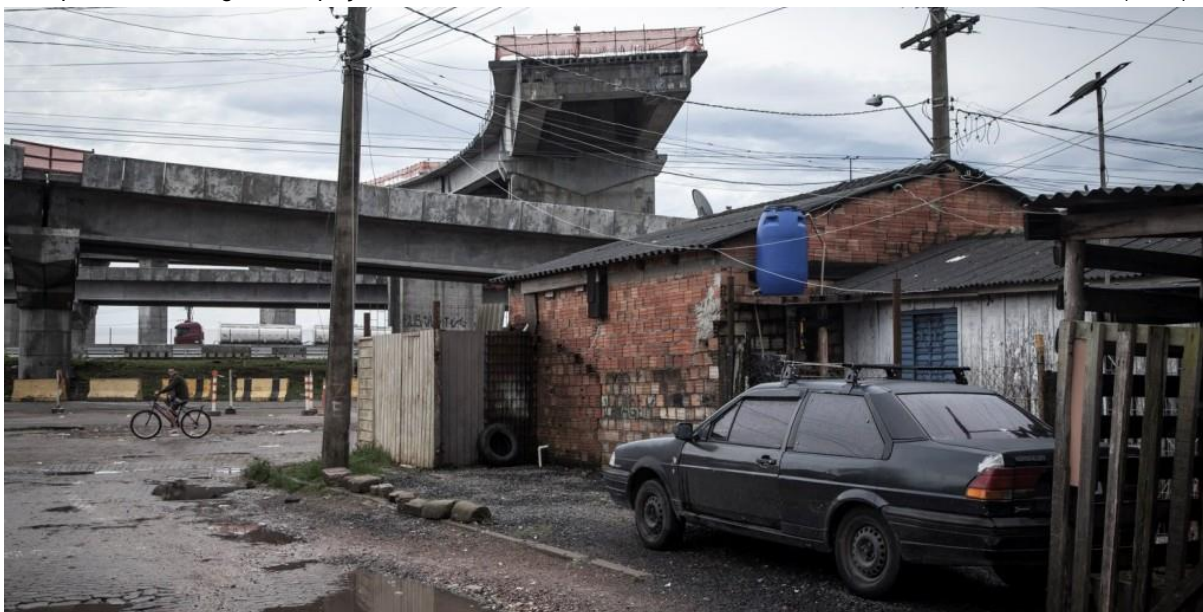
Ocupação Cobal e ao fundo a alça de acesso da nova Ponte do Guaíba
